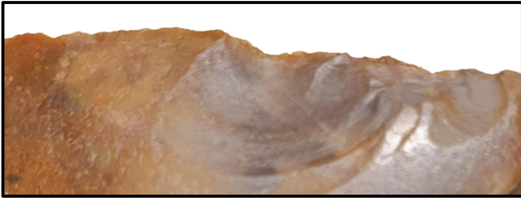
Detailopname van recente beschadiging
